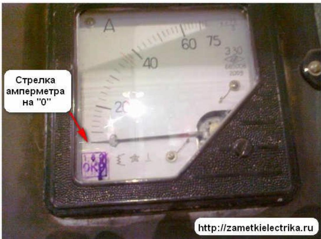
2. Проверим фактическое отключение масляного выключателя.
