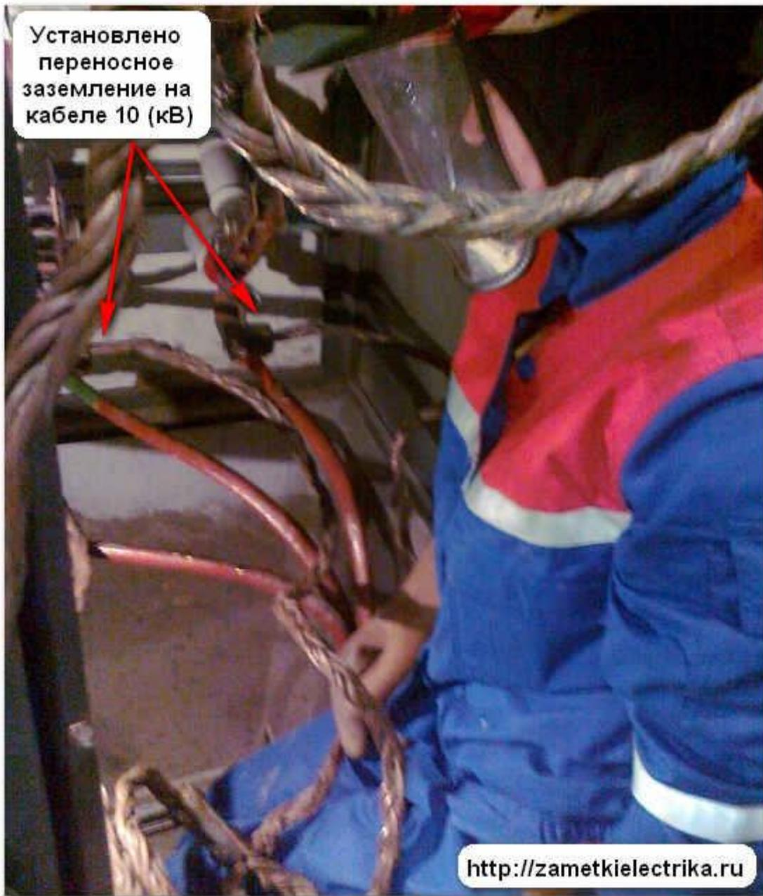
*устанавливать и убирать переносные заземления необходимо ТОЛЬКО в диэлектрических перчатках. Устанавливать переносные заземления в электроустановке выше 1000 (В) могут два работника с IV и III группами по электробезопасности.*
