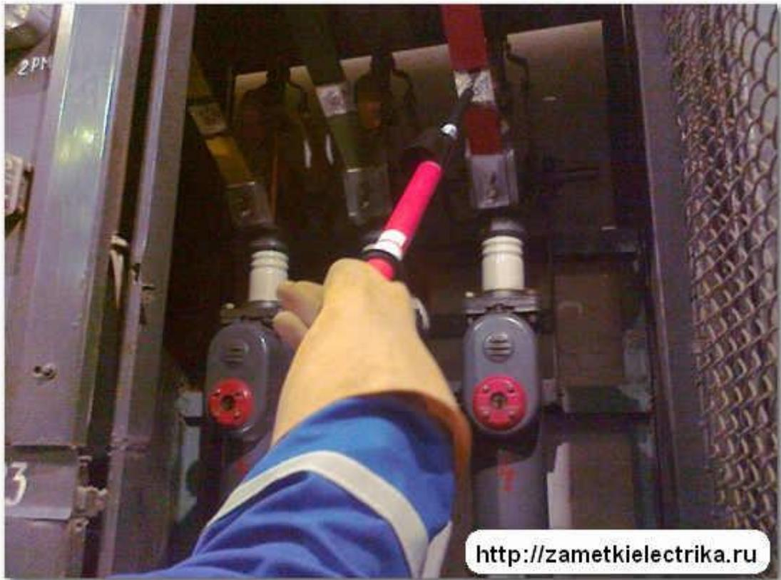
10. Установим переносное заземление в ячейке масляного выключателя 10 (кВ) со стороны сборных шин.
