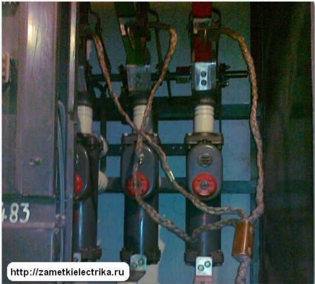
После установки переносных заземлений на рукоятках ручных приводов шинного и кабельного разъединителей повесим указательные плакаты «Заземлено».
