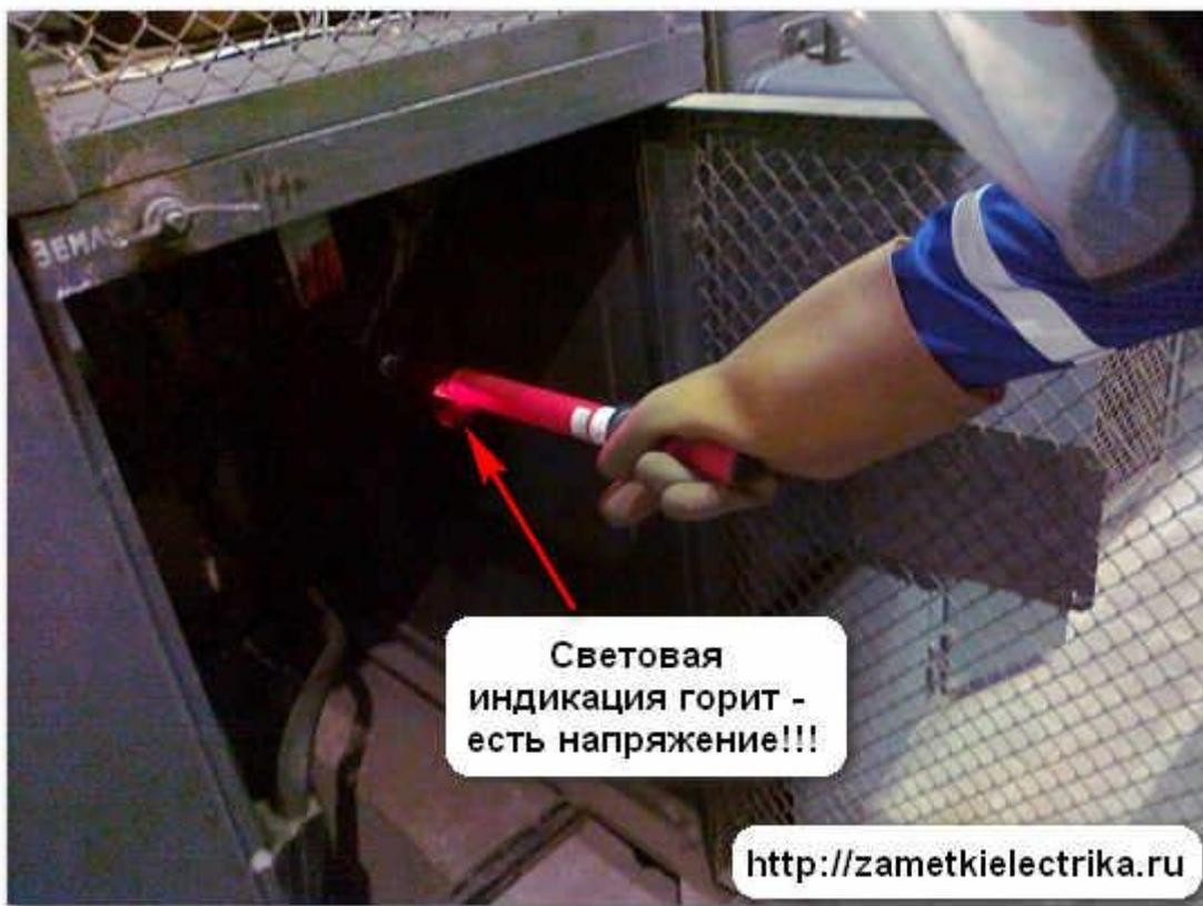
А теперь проверим отсутствие напряжения на силовом кабеле 10 (кВ) нашей ячейки.
