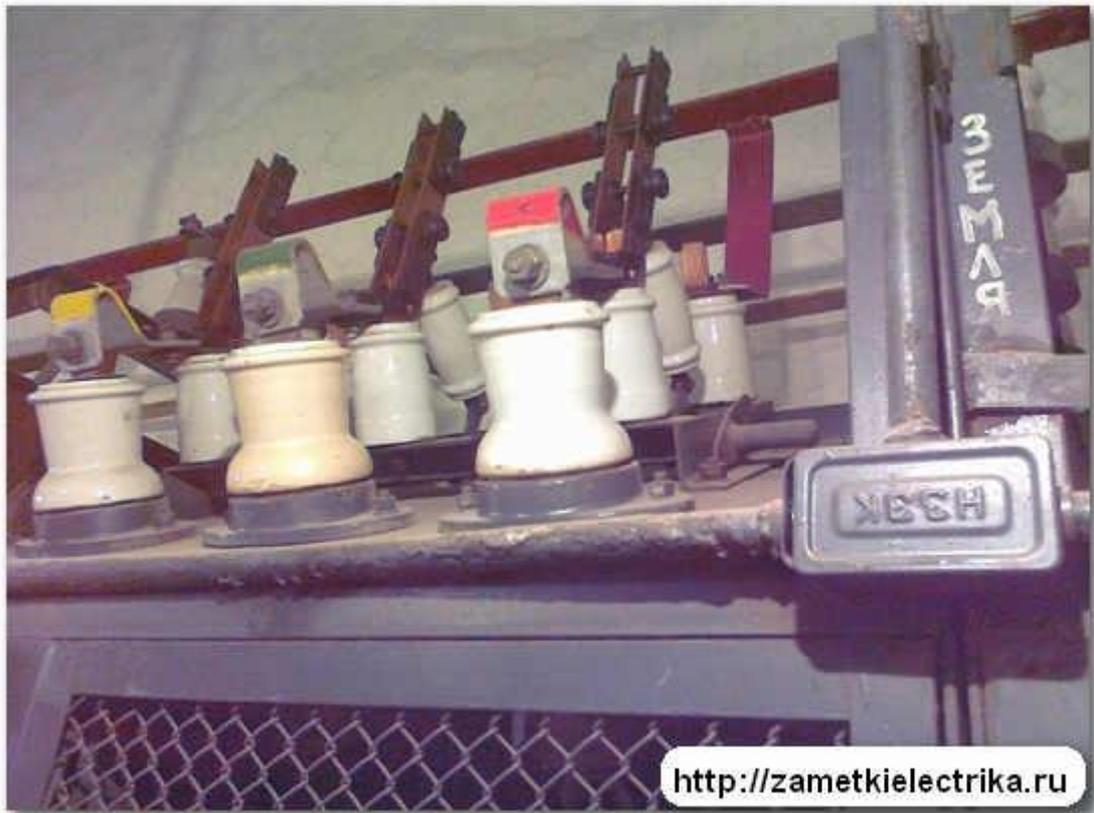
После отключения шинного и кабельного разъединителей убедимся, что они отключились — должен быть виден разрыв между подвижными и неподвижными контактами.
