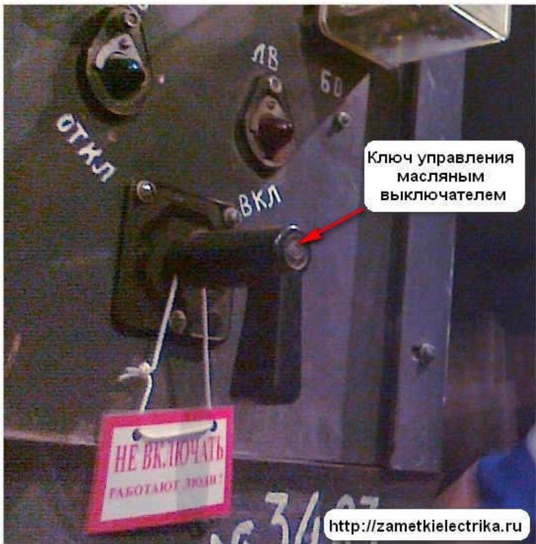
На ключ управления масляным выключателем тоже повесим запрещающий плакат «Не включать! Работают люди».
